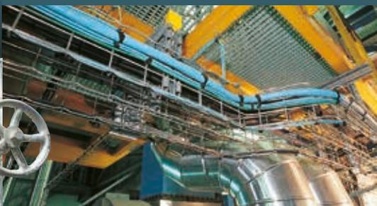
Las varillas de acero de alta calidad, electrosoldadas de manera homogénea y controlada; con borde de seguridad en T único y patentado, hacen de Cablofil la bandeja más probada, especificada y certificada del mundo.
