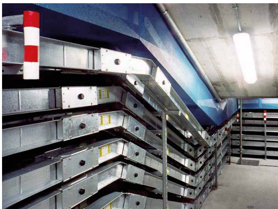
Ejemplo de distribución de alta potencia.
